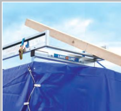
Lastenträger oberhalb der Plane bei CombiCover TOP mit optionaler Laderolle
